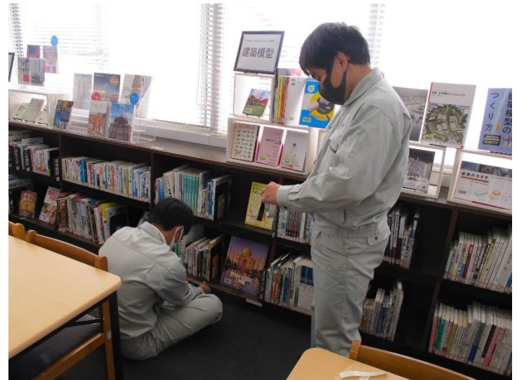
↑ 本を揃えるための棚板も南北窓下書架に全て設置完了！
