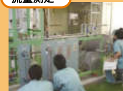
▲管内の流量の測定
